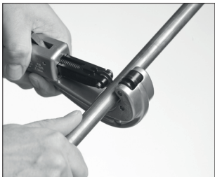
KAPNING AV RÖR
